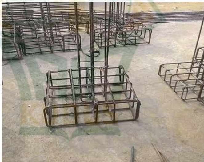
Gambar 2.2 Cakar Ayam di Toko Bangunan Al-Amin Kudus
