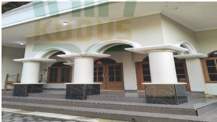
Gambar 4. 7 Gedung Serba Guna
