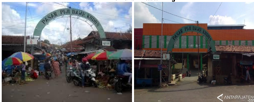
Gambar 4.5 Kondisi Pasar Piji
