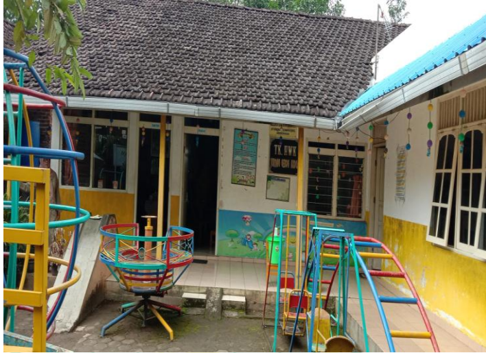
Gambar 4.1 Gedung TK HWK Jurang, Gebog, Kudus
