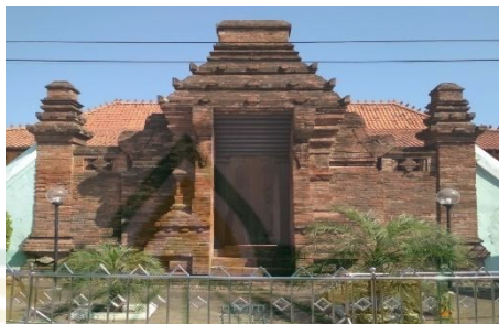
Gambar 2.4 Gapura Padureksan Masjid Wali Al-Makmur
