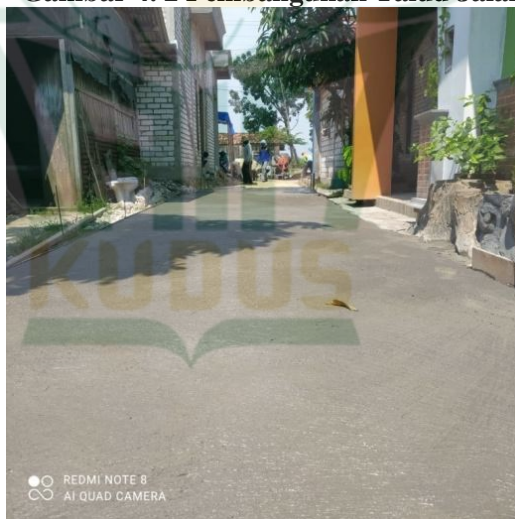
Gambar 4. 3 Pembangunan Jalan Usaha Tani
