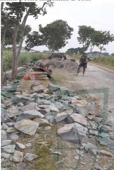
Gambar 4. 2 Pembangunan Talud Jalan
